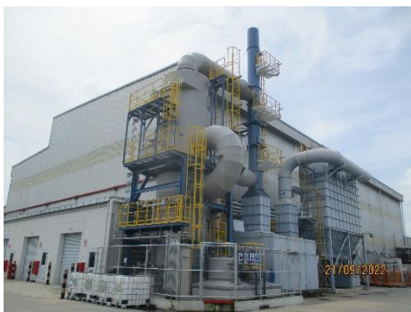
รูปที่ 36 ระบบบำบัดมลพิษทางอากาศแบบ Wet Scrubber
