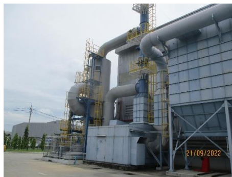
รูปที่ 36 ระบบบำบัดมลพิษทางอากาศแบบ Wet Scrubber
