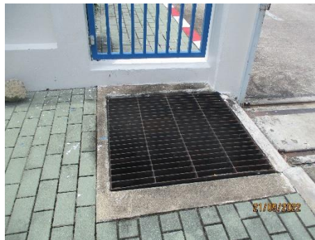
รูปที่ 17 จุดเชื่อมต่อกับรางระบายน้ำของนิคมอุตสาหกรรมอมตะซิตี้ (ระยอง)
